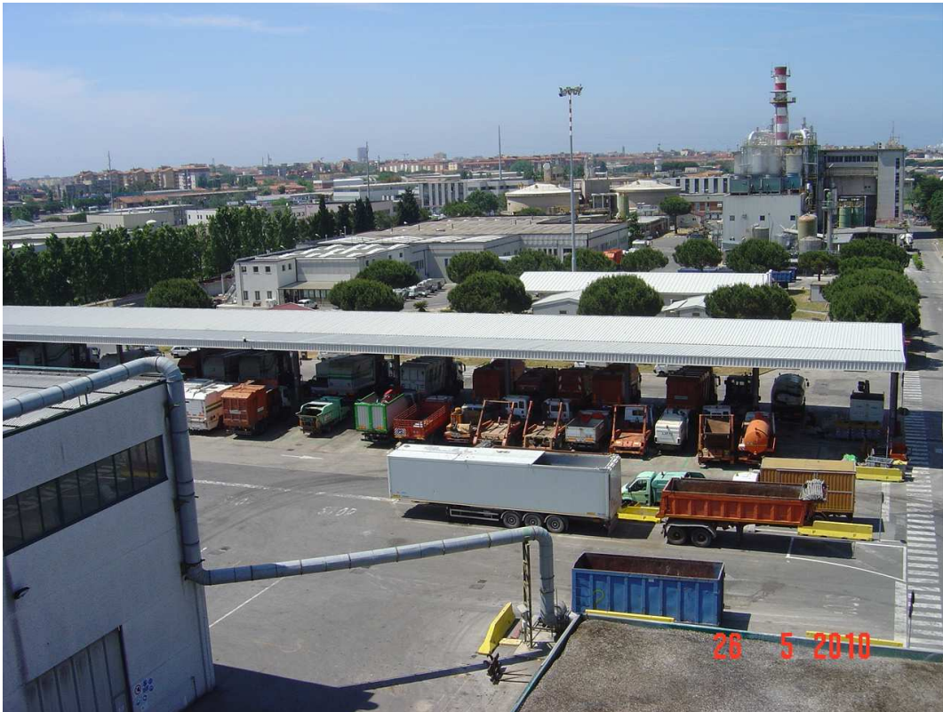
Figura 2 - Particolare pensilina ricovero automezzi
