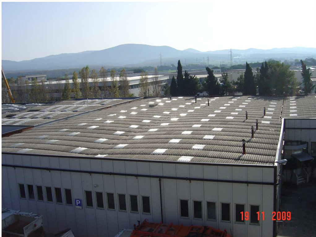
Figura 1 - Particolare copertura officina con annessi
